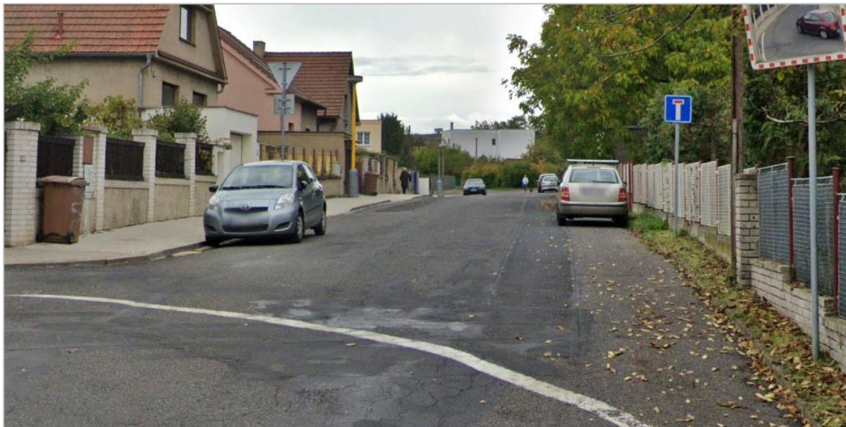
31/ Nadměrná šířka komunikace v obytné oblasti (ulice Houskova)
