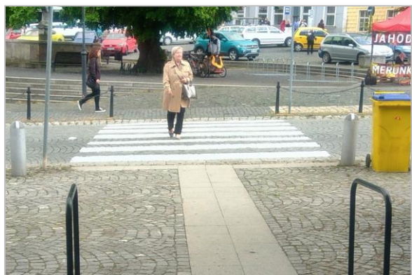
95/ Signální a varovný pás (zde z nesprávného materiálu) na opačné straně komunikace zcela chybí
