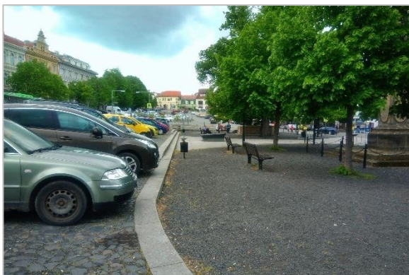
74/ Neorganizovaný, bariérový a nebezpečný přístup do středu náměstí skrze parkovací plochy
