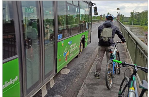
49/ Nedostatečná šířka chodníku na Špindlerově mostě; řidič autobusu navíc mírně přesahoval do protisměru, aby se osobám na chodníku vyhnul
