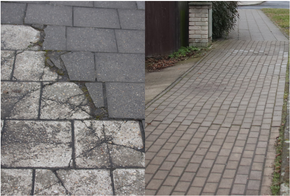
detaily původní betonové dlažby, která mezi zpevněnými pochozími povrchy tvoří naprostou většinu, ale na mnoha místech již není v dobrém stavu
