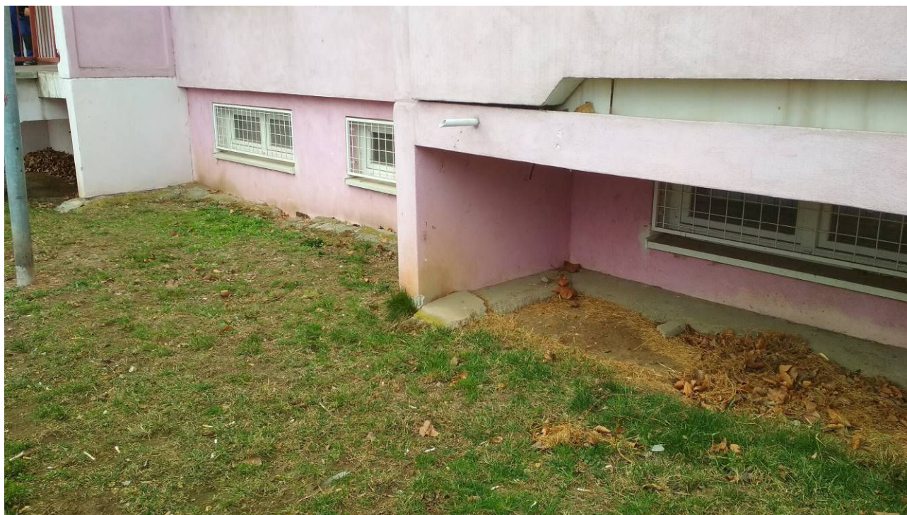
Obr. 13 – sokl objektu s degradací a propady okapových chodníků
