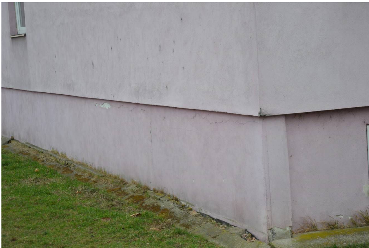
Obr. 14 – sokl objektu s degradací a propady okapových chodníků a povrchových úprav panelů 1.PP
