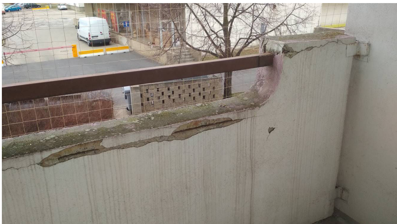
Obr. 12 – železobetonové zábradlí lodžie s degradací betonu a obnažující se pomocnou výztuží
