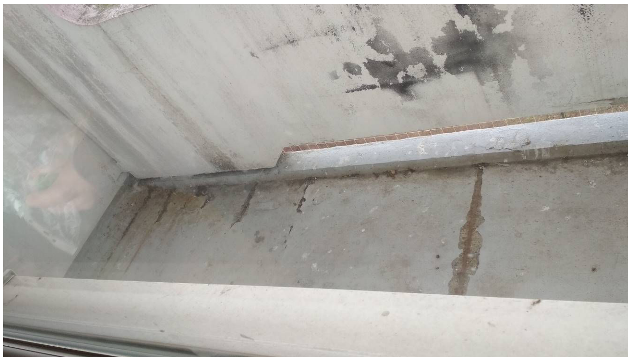
Obr. 11 – podlaha lodžie s obnaženou a korodující rozdělovací výztuží
