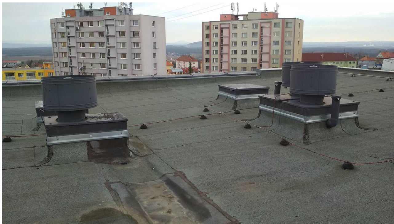
Obr. 09 – střecha objektu s nástavbami odvětrání bytových jader s fixními ventilačními hlavicemi
