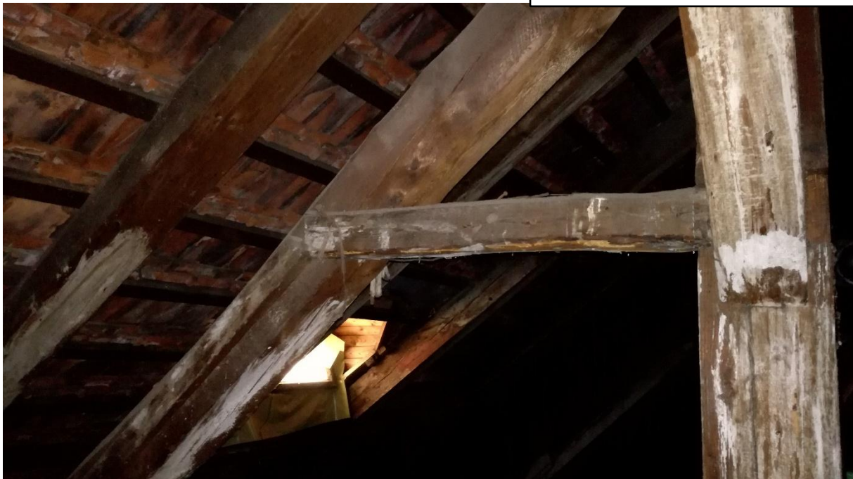
Nepochopitelně umístěné dřevěné prvky v konstrukci střechy.
