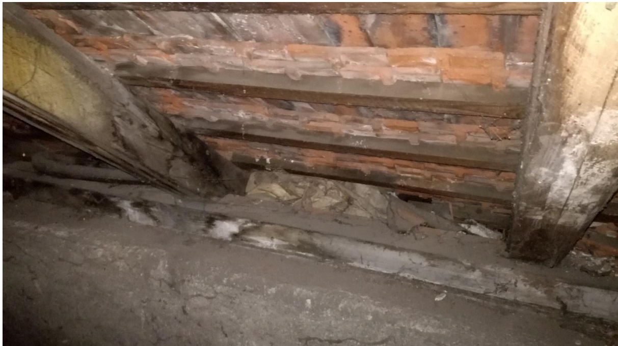
Za pozednicí je umístěno velké množství stavebního odpadu.
