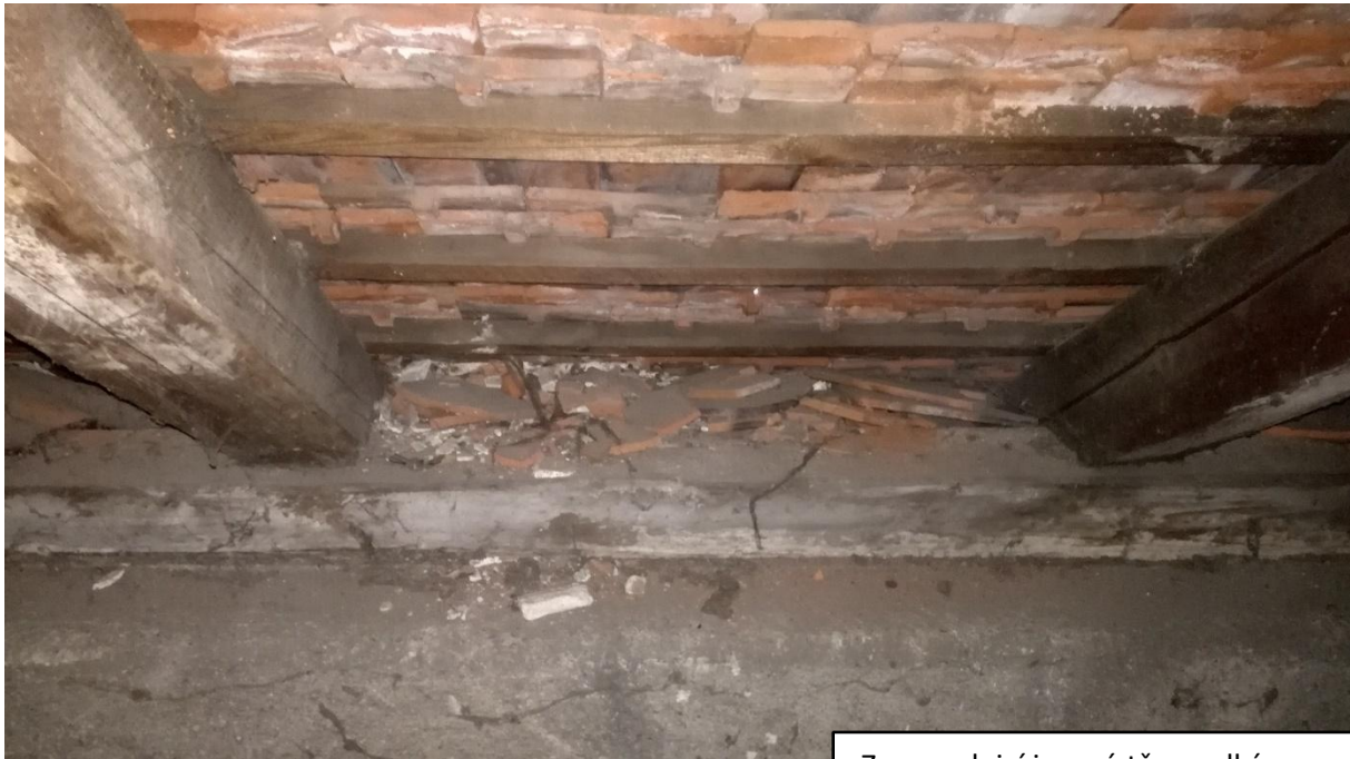
Za pozednicí je umístěno velké množství stavebního odpadu.
