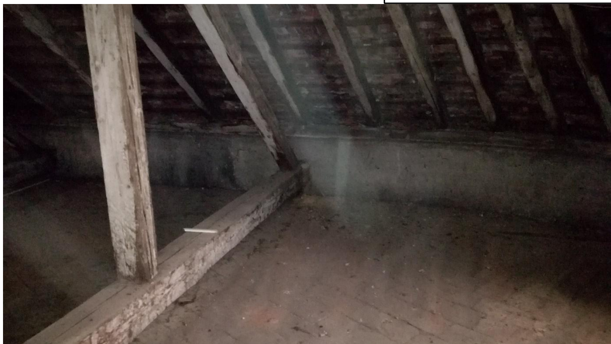
Viditelné napadení vazného trámu dřevokazným hmyzem (požerek na podlaze půdy).
