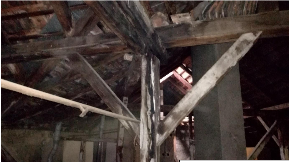
Nepochopitelně umístěné dřevěné prvky v konstrukci střechy.
